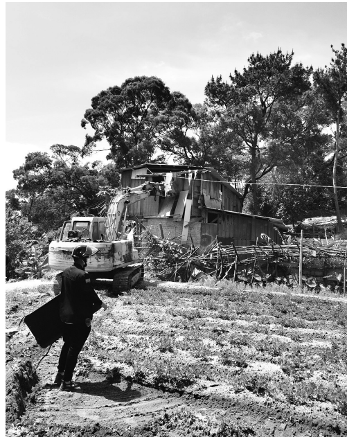
马尾镇拆除建板村后山一处违建
