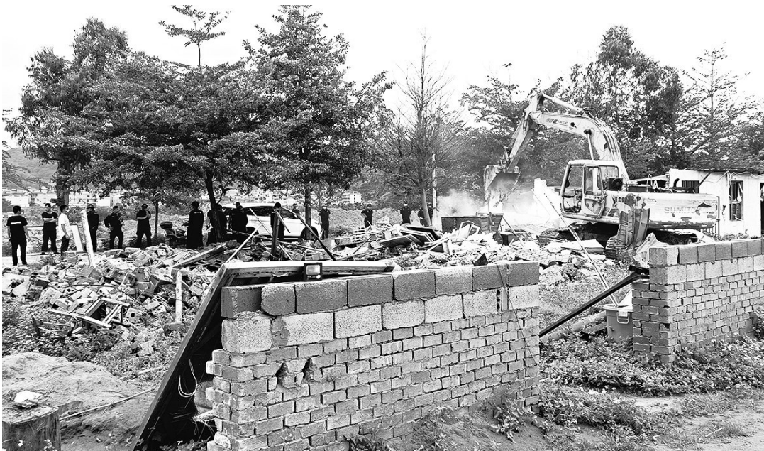
琅岐镇拆除金沙管理区的养殖场违建
