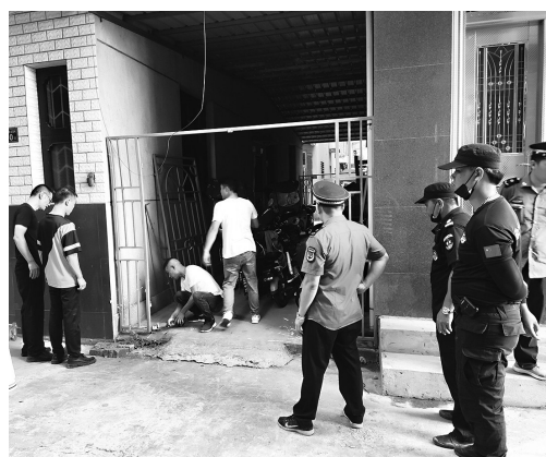
琅岐镇拆除上岐管理区占道杂搭
