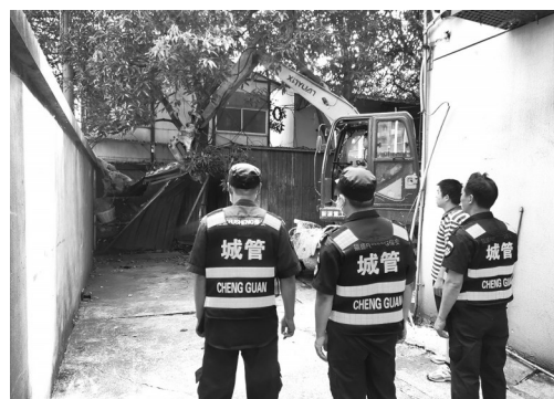
罗星街道拆除港口路茂盛大厦一处违建
