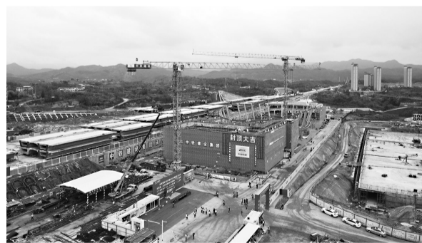
龙龙铁路上杭北站,站房主体结构封顶
