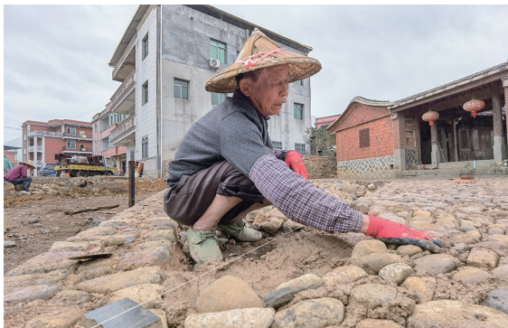
“顶点金”厝前埕正在重铺鹅卵石地面
