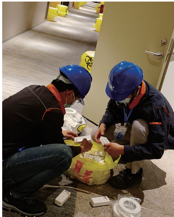
隔离点安装智能门磁
