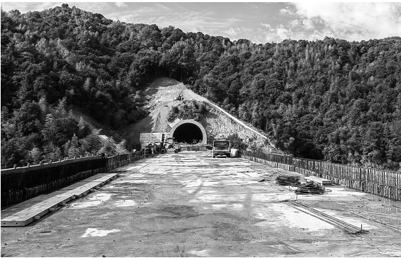
龙岩至龙川铁路福建段最长隧道——双髻山隧道于 10 日凌晨顺利实现贯通
