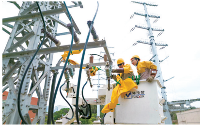
国网惠安县供电公司带电作业人员更换发热刀闸(黄泽缘摄)
