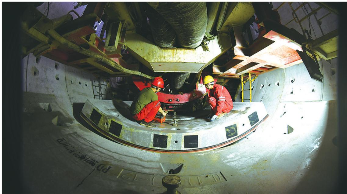
施工人员在狭小的空间内操作设备安装管壁
