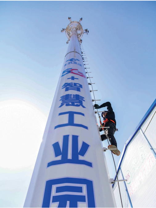
永春九牧园区5G基站铁塔
