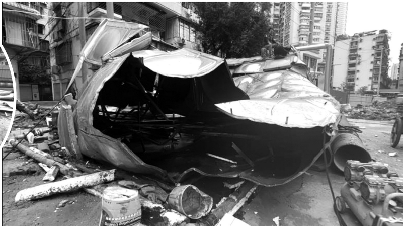
爆裂的温泉水箱箱体
