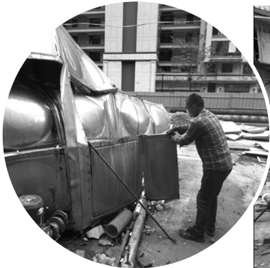
3日下午,工人正在拆除水箱铁皮
