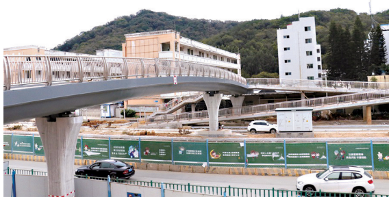
人行天桥桥梁主体架设完成
