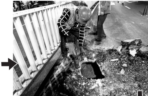
在井大路,工作人员对问题道路“微创”施工
