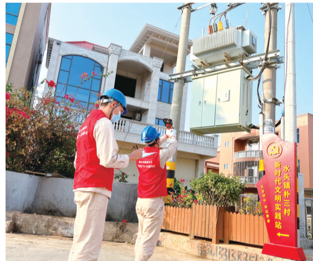
国网南安市供电公司开展沿海污区配电设备特巡特护
