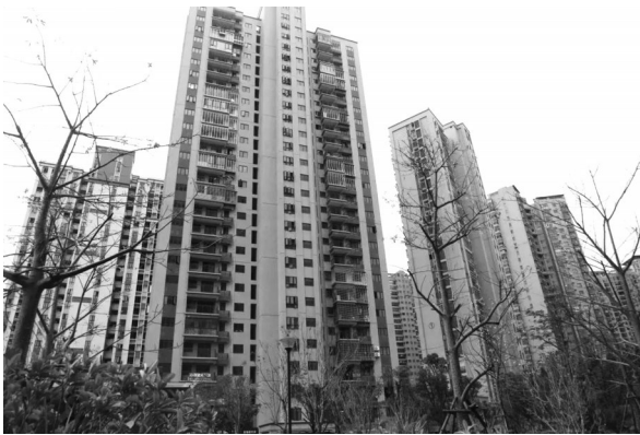
西福花苑小区已交房，业主陆续进驻装修
