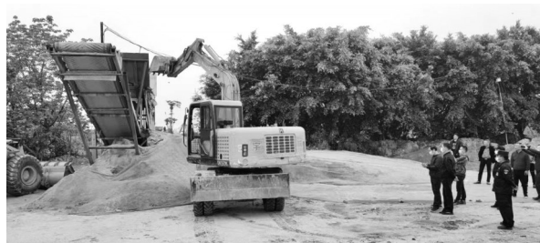
联合执法取缔阳岐排涝站外非法堆沙场
