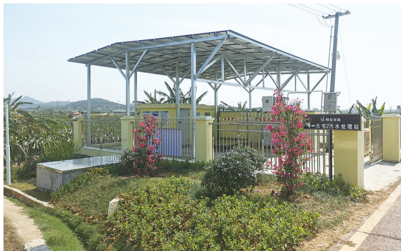
厦门翔安大宅社区污水处理站
