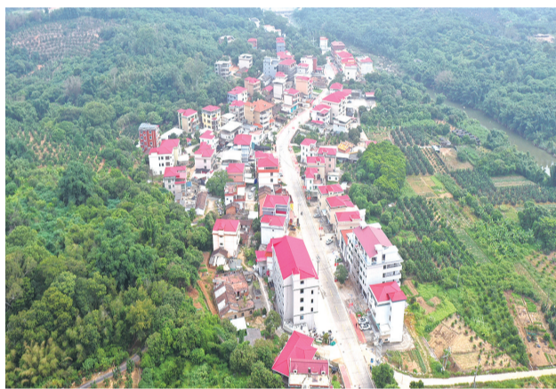
漳州长泰区坂里乡丹岩村裸房整治后，古村焕新颜
