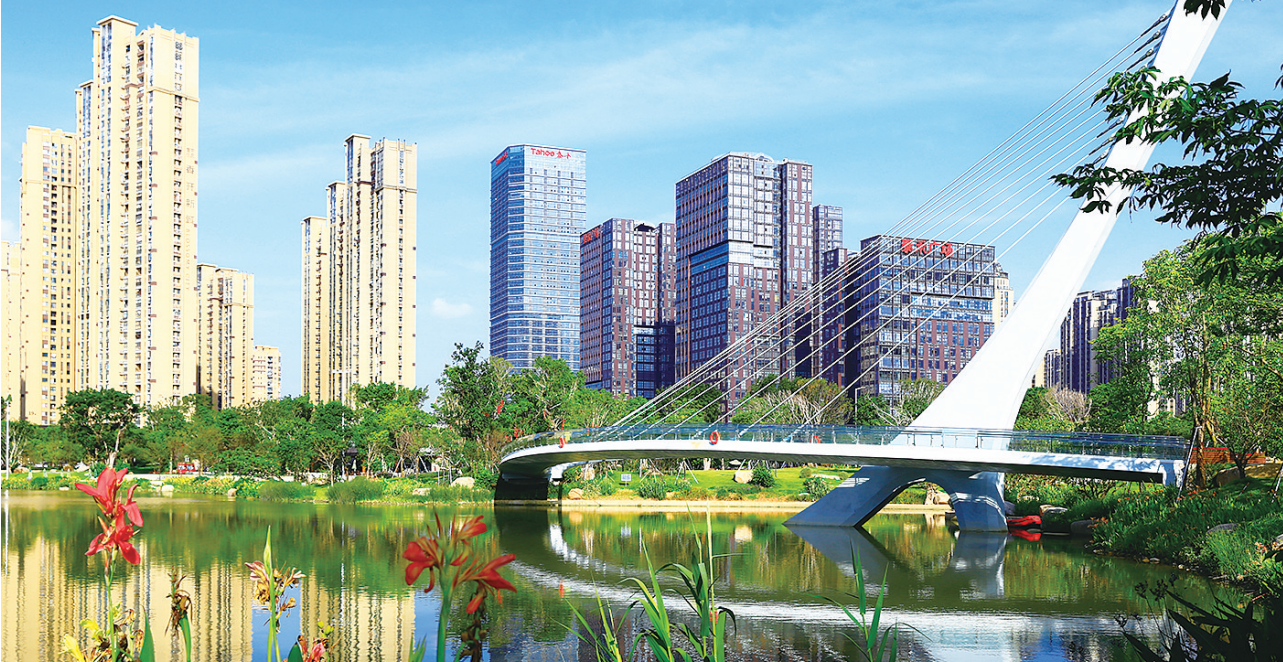
晋安湖公园配建8座景观桥
