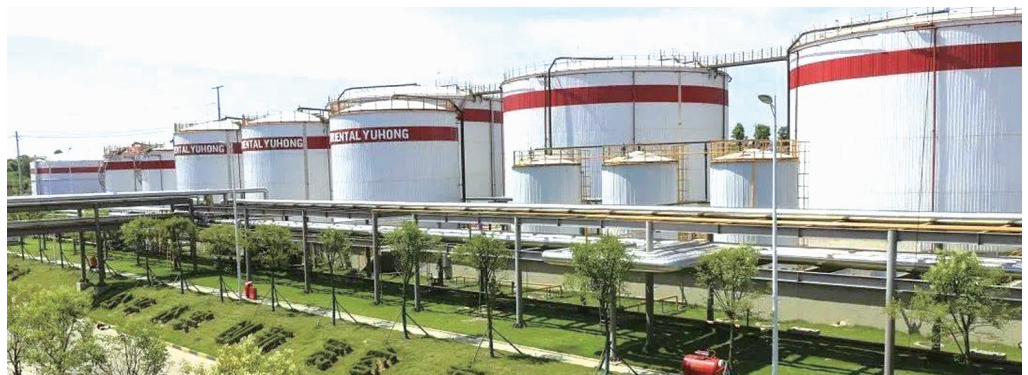
▼福州绿色建材生产基地及福建区域总部项目
