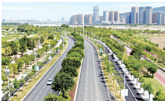
南江滨东大道路面平整,两侧绿意盎然
