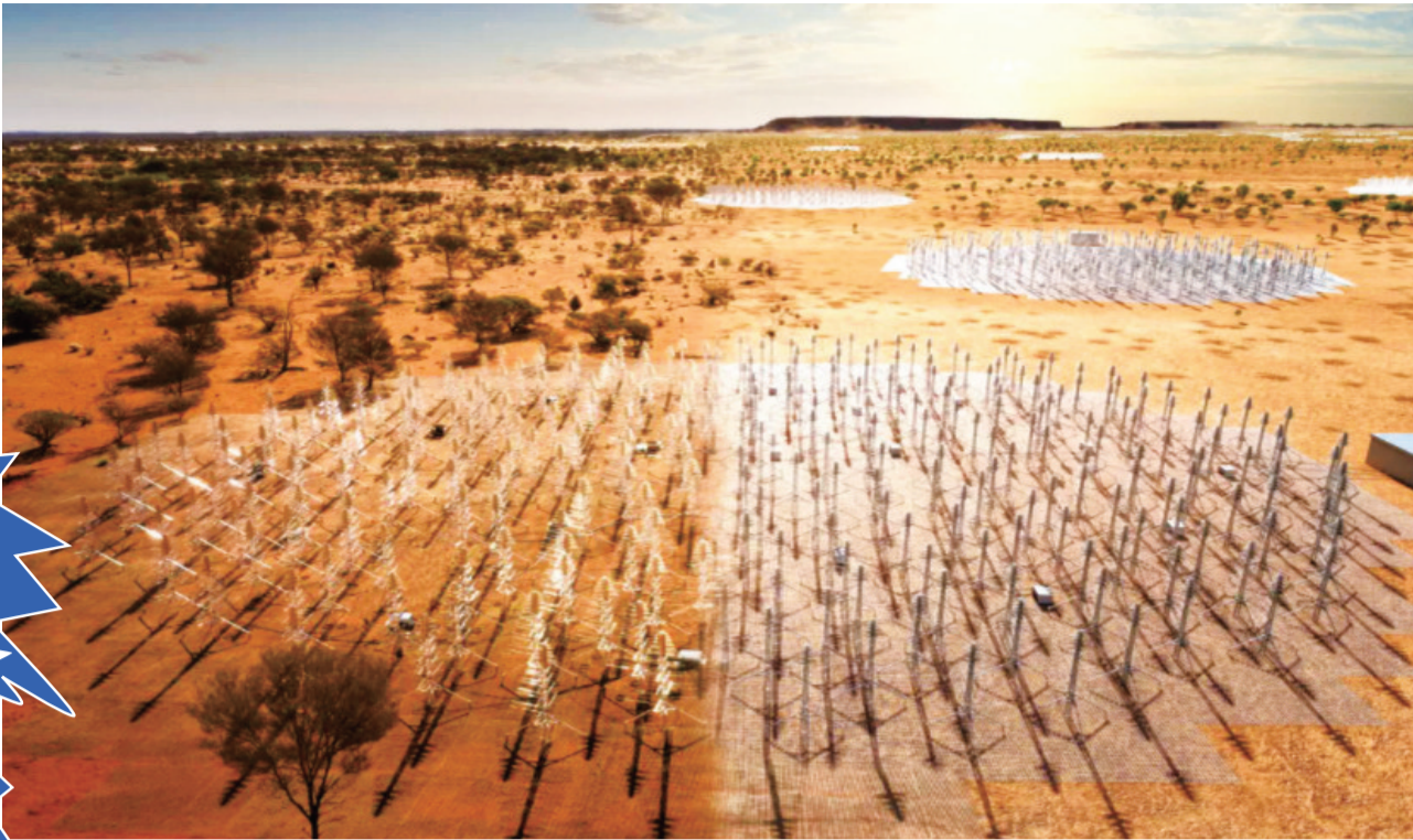
无线电天线站艺术图。每个站有256个天线,SKA-Low望远镜将有512个站
