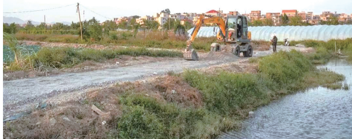
田园漫步项目改造施工现场
