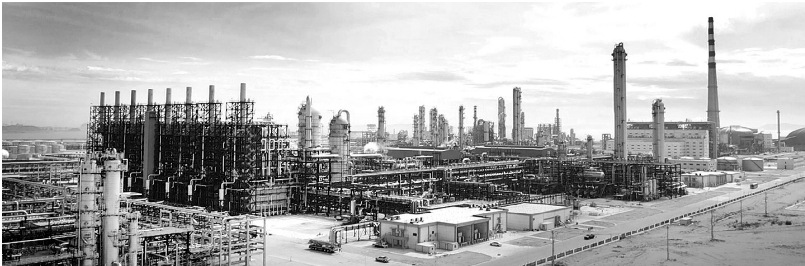
古雷炼化一体化项目航拍图(詹照宇供图)
