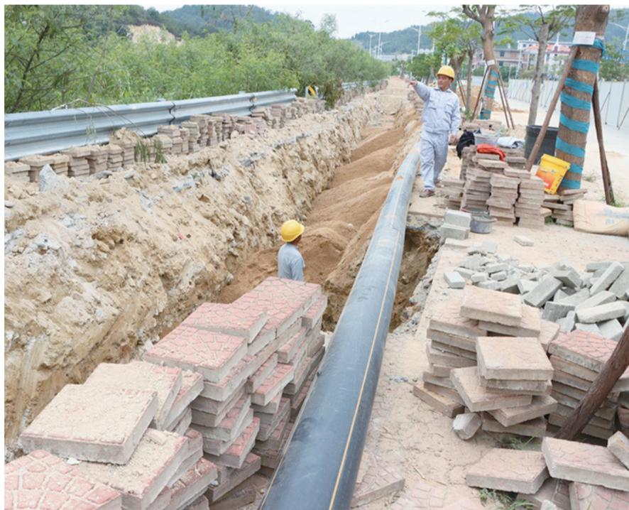
工人正在铺埋供水管道,其中主管道管径为700毫米
