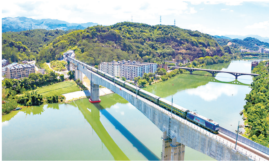
兴泉铁路清流段试运行列车经过沙溪特大桥
