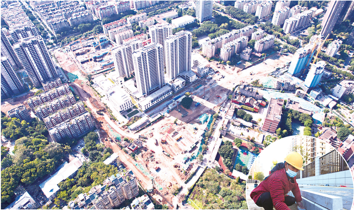
塔头片区项目航拍
