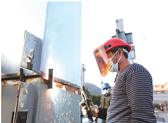
福州职业技术学院的工地里,一名工人正在焊接钢梁
