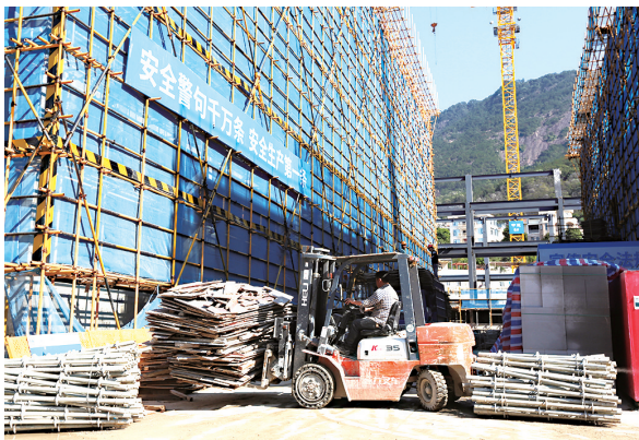
福州市委党校项目工地里,工人正在操作叉车搬运货物
