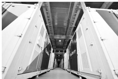
大连液流电池储能调峰电站的电池集装箱(中科院大连化学物理研究所供图)
