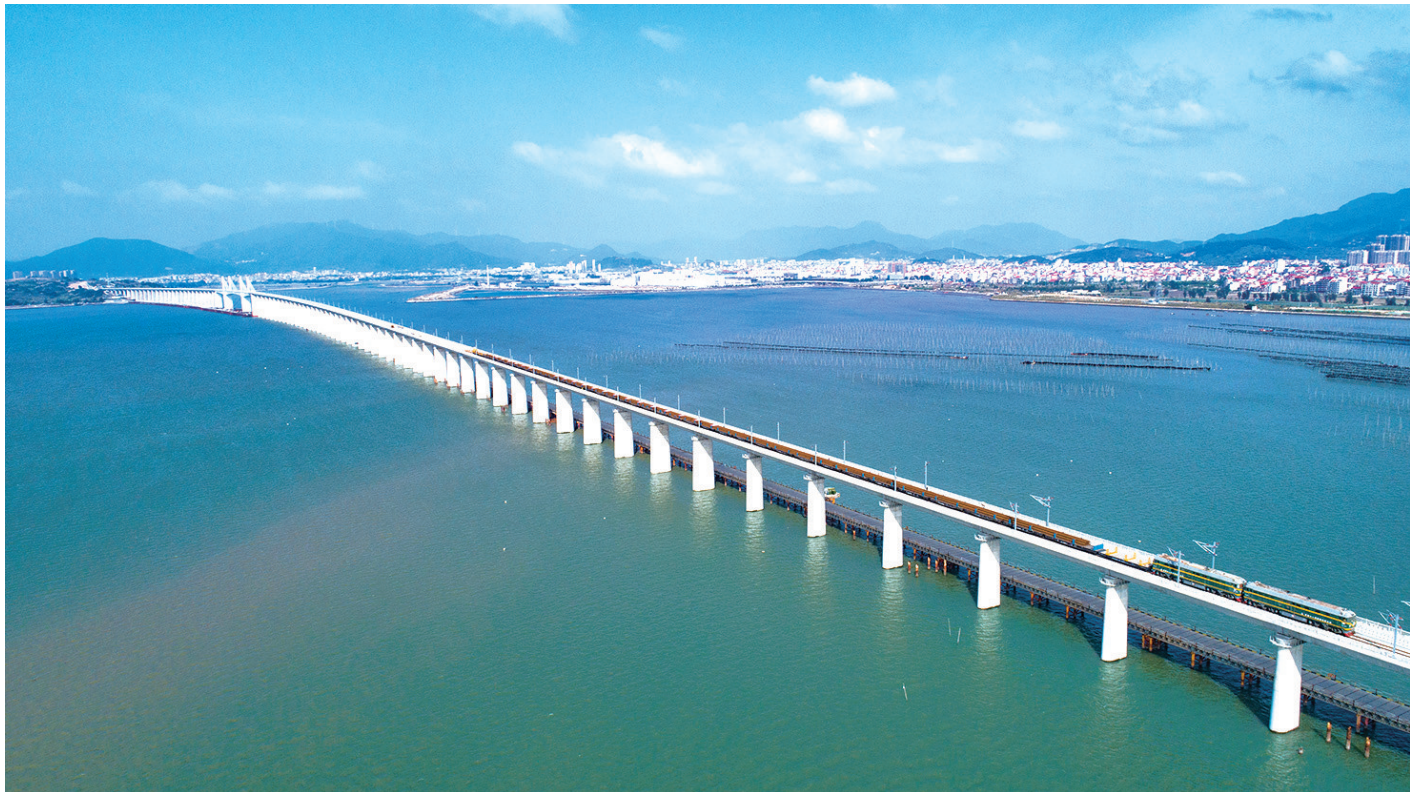
新建福厦铁路湄洲湾跨海大桥(新华社/图)
