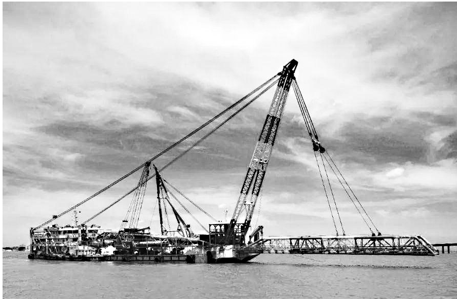
“一闸三线”工程项目现场(资料图)
