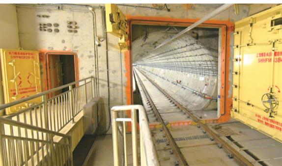
福州地铁6号线林浦站内,道床大型人防门边,设置了可以过人旁门(图左)连通疏散平台
