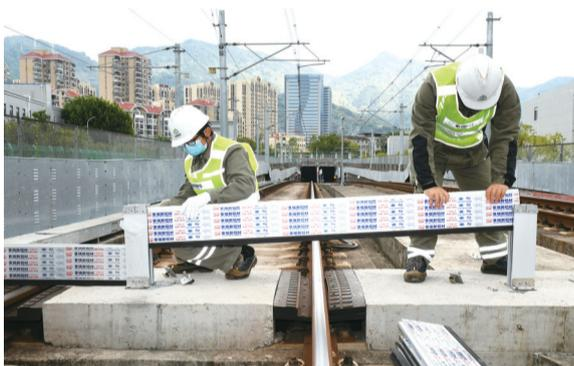
出入段线敞口处轨道间增加了多个混凝土“平交口底座”,方便了防洪挡板的安装
