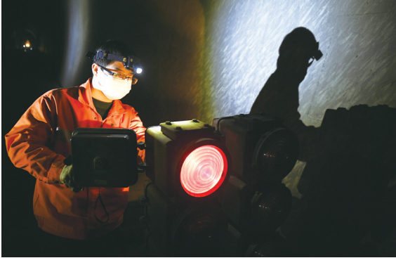
检修人员在上岐隧道内,检查信号机的灯光设备
