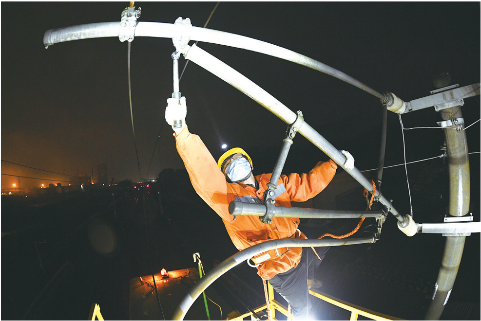
福州供电段杜坞供电工区的工作人员正在检修接触网
