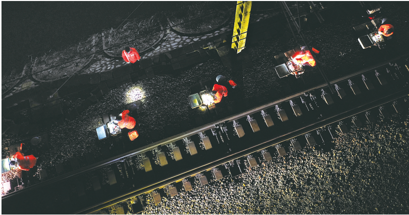
凌晨1时,福州电务段樟林三所信号工区的工作人员开始检修转辙机
