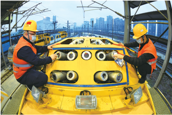
4C接触网检测车顶上装有摄像头等监测设备,日常需要清洁保养
