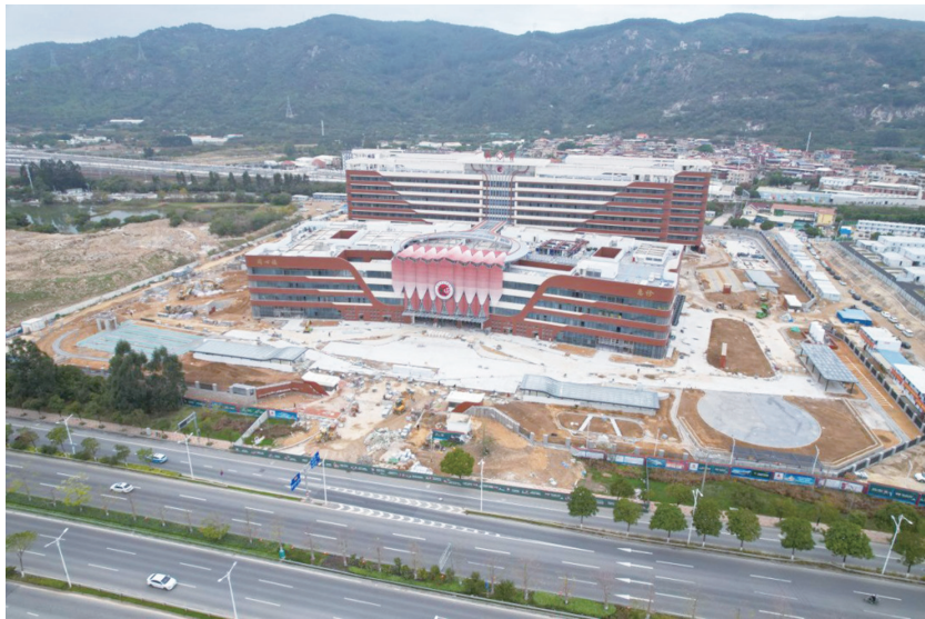
泉州市正骨医院北峰院区,项目已进入扫尾阶段
