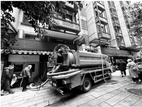
工人在现场进行处理
