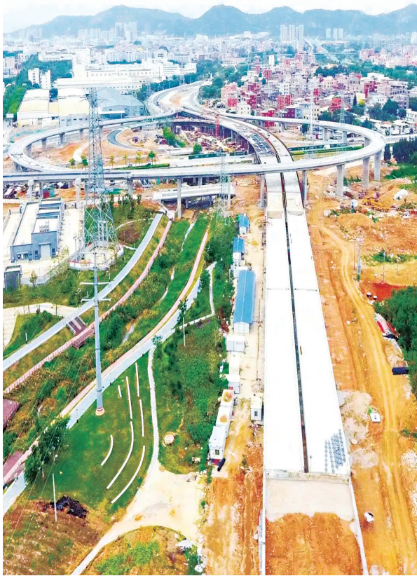
晋江南高速出口连接线延伸段工程主线高架桥全线贯通, 高速主线按时恢复通车
