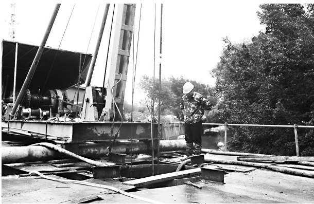
尤溪洲南立交项目工地里,工人正在观察打桩机的运转情况
