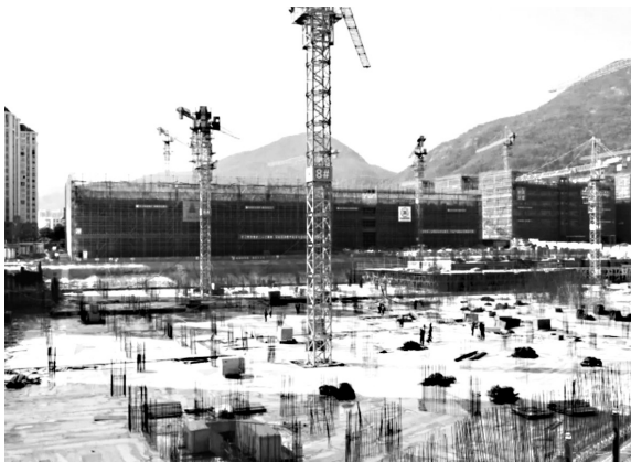
洛江数字经济产业园(一期)现场如火如荼
