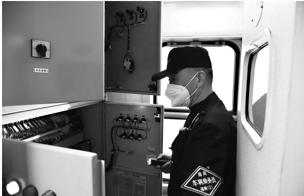
乘务员梁建雄在检查配电柜
