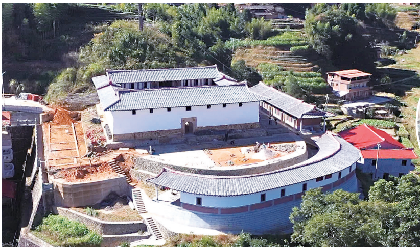
福洋土楼修缮将于10月全部完工
