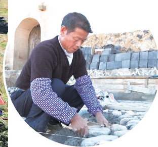
工人正在铺设鹅卵石地面
