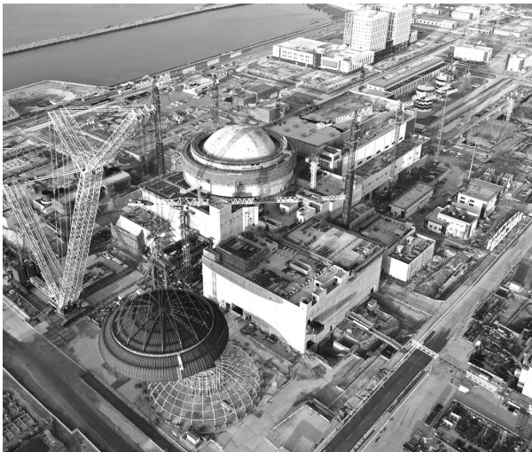
漳州核电1号机组外穹顶成功吊装(央视/图)
