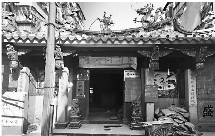
永潮宫门口的施工脚手架已拆除
