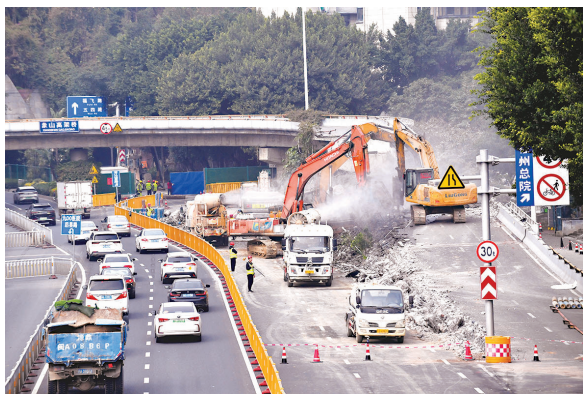
19日,象山高架桥开拆
