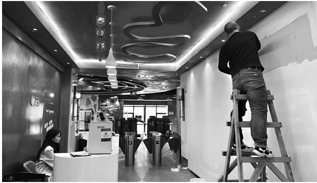
“飞领时代”五四路店大厅有工人正在装修
