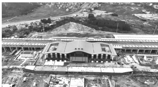
正在建设的泉港高铁站
