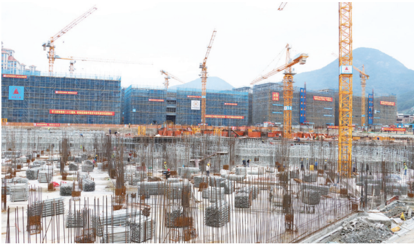
洛江区数字经济产业园(一期)施工现场
