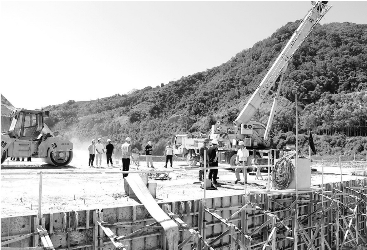
泉州白濂水利枢纽工程大坝施工现场
