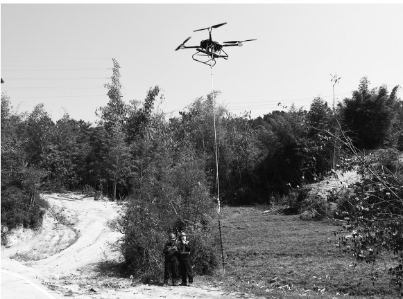
工作人员运用重载无人机,将检修物料和施工器具运送至山顶
