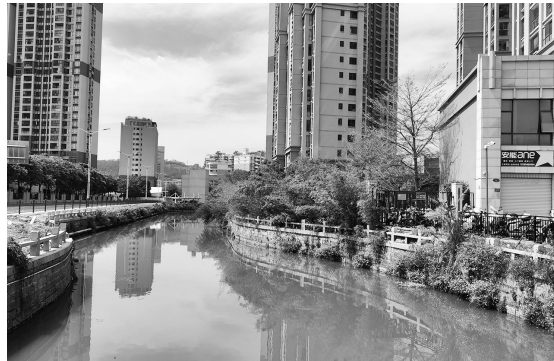
路面已全部完工,岸渠也已重新绿化
