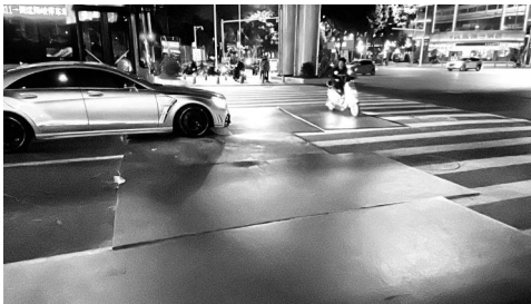
铺在路面上的铁板
