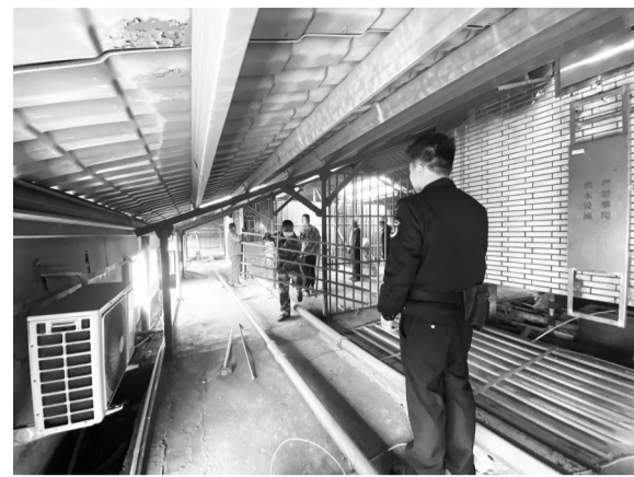
顶楼违建被拆除
