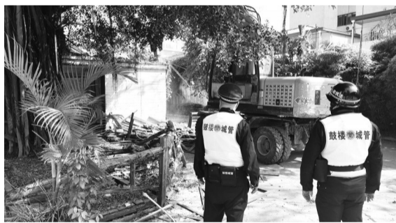
园区内一处违建被拆除
