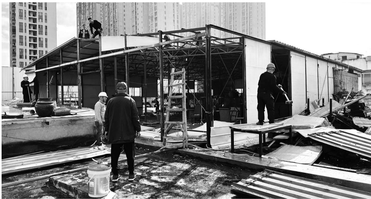
拆除小区楼顶违建
