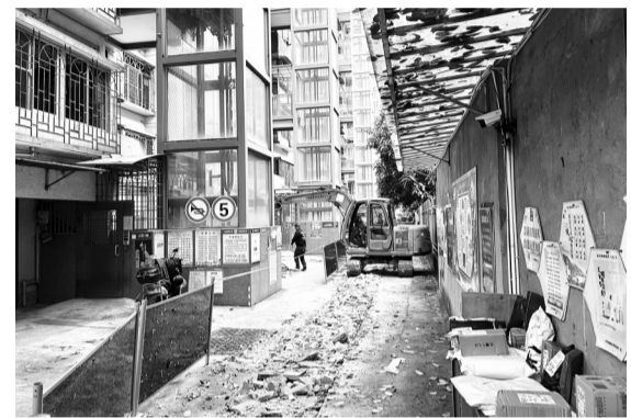
26日下午4时,小区内正在施工
