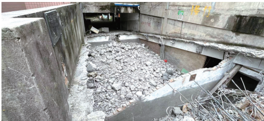
地下室通道被完全拆除
