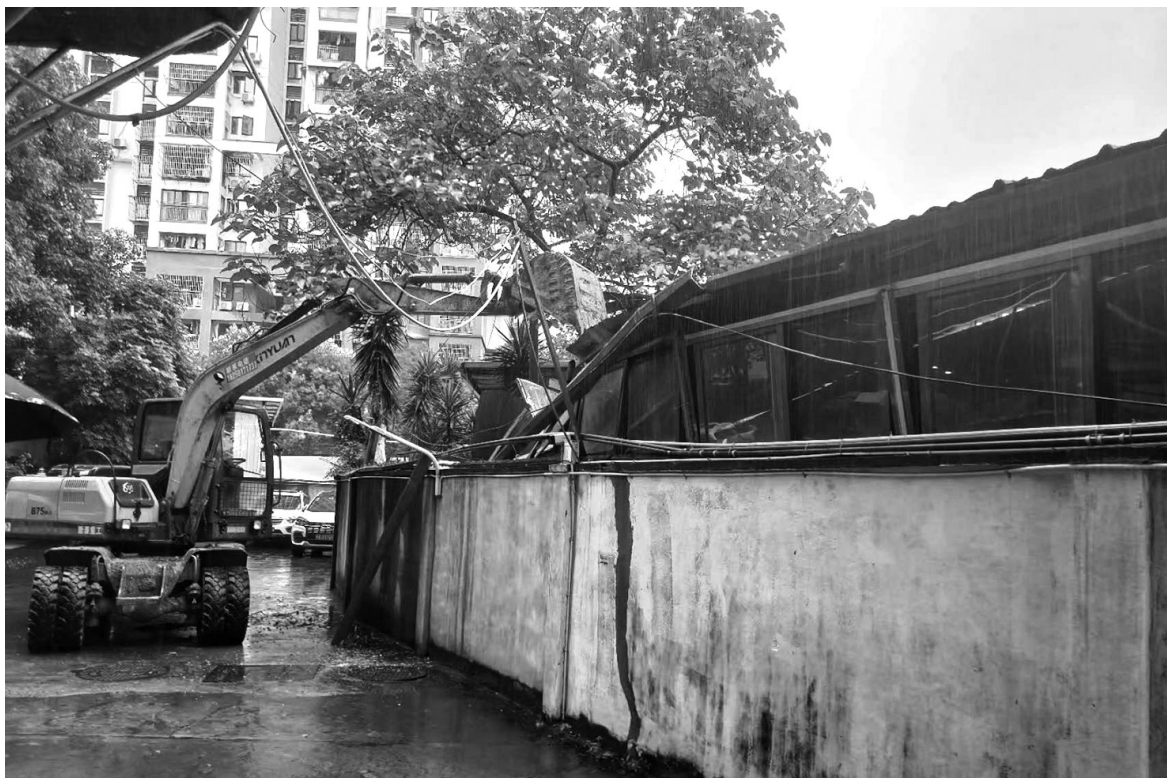
鑫怡公寓门口违建宗教场所被拆除
