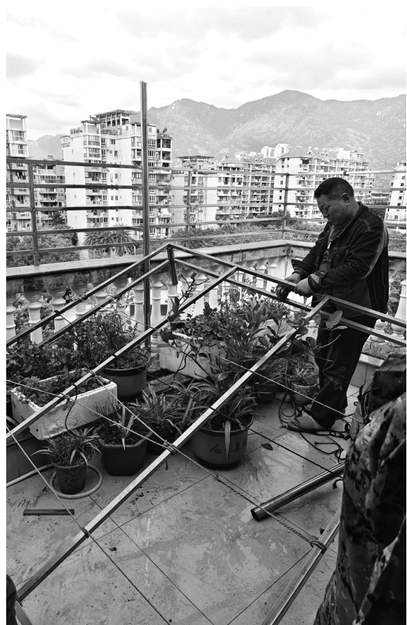
执法人员拆除光明世家3号楼楼顶违章搭盖
