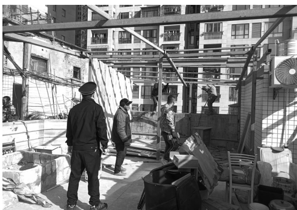
义洲中队执法人员拆除一处楼顶违建
