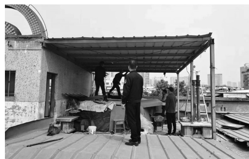
一处违建铁皮屋被拆除
