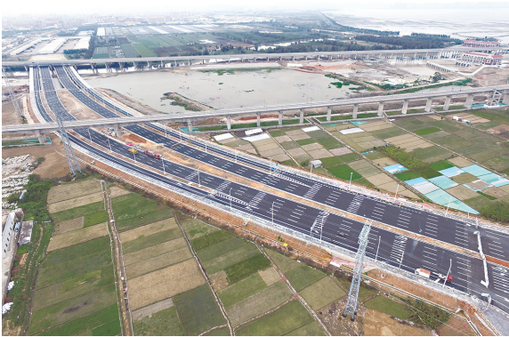
该路段双向八车道,下穿福厦高铁和泉州绕城高速
